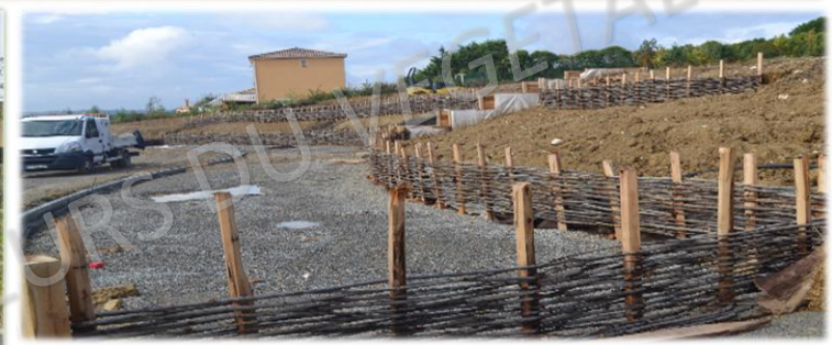
Aménagements, génie végétal
